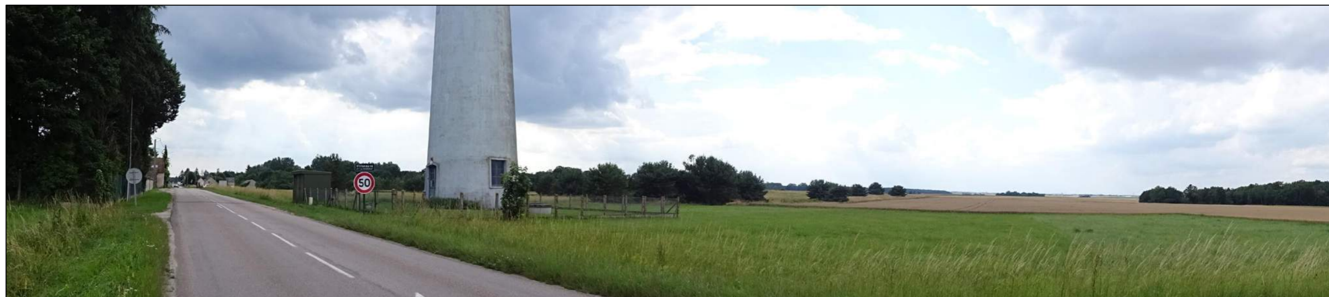
Vue 2' : Vue panoramique depuis l'est du site d'étude en direction du sud-ouest
