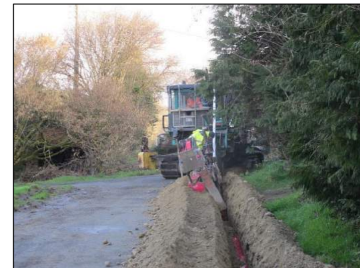
Figure 33 : Trancheuse pour enfouissement des câbles HTA (Source : SOG SOLAR)
