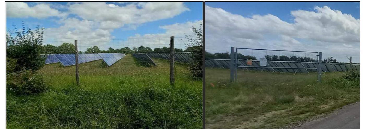
Figure 35 : Exemple de grillage et portail d'accès
