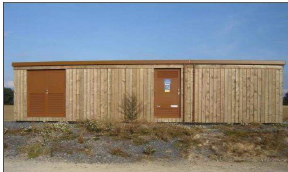
Figure 28 : Exemple d'un poste de livraison en bardage bois (Source : cahors)
