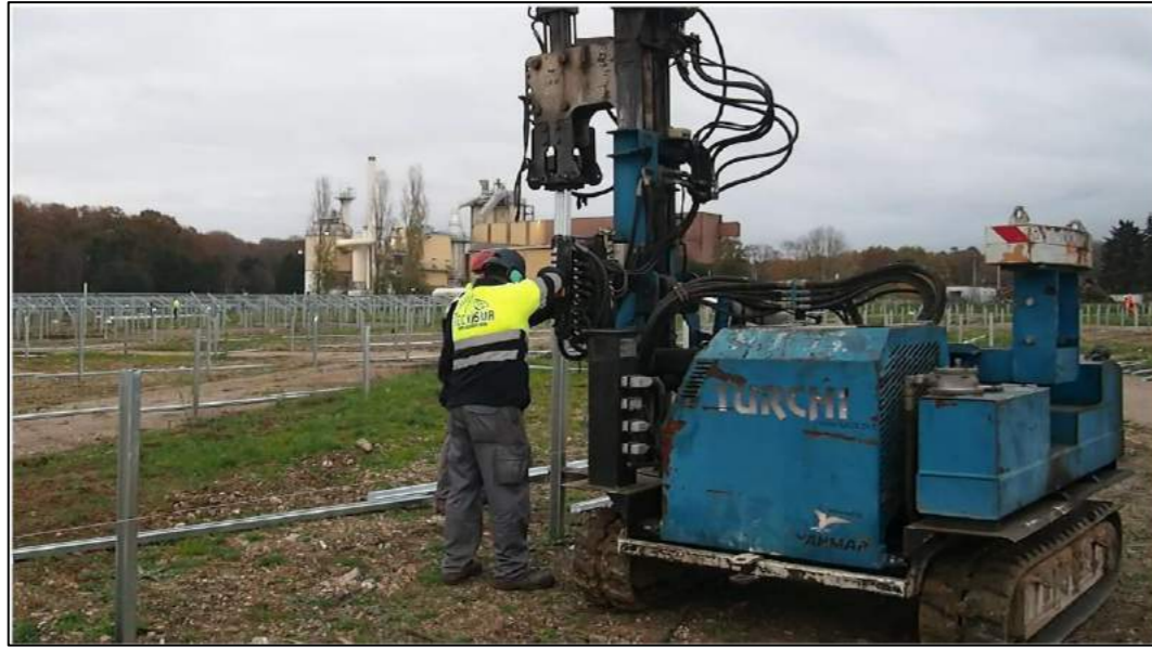
Figure 24 : Battage de pieux (Source : SOG SOLAR)
