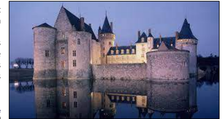
Figure 48 : Château de Sully-sur-Loire (Source : chateausully.fr)
