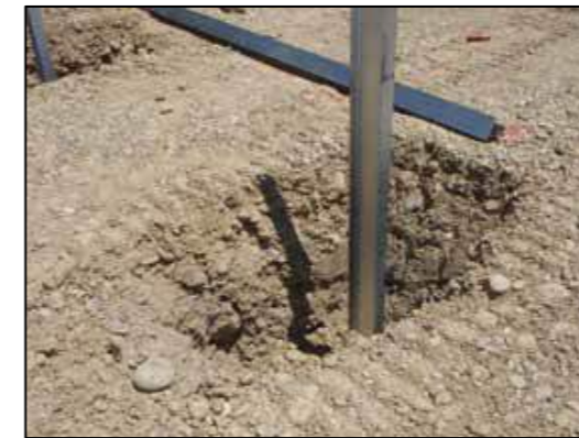
Figure 21 : Types de fondation - pieux battus (Source : Guide MEDDTL 2011 – NCA, 2015)
